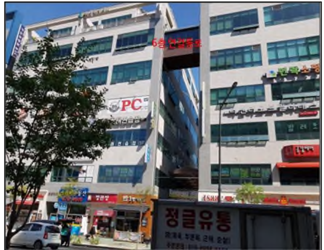
[ 6층 연결통로 전경 ]
