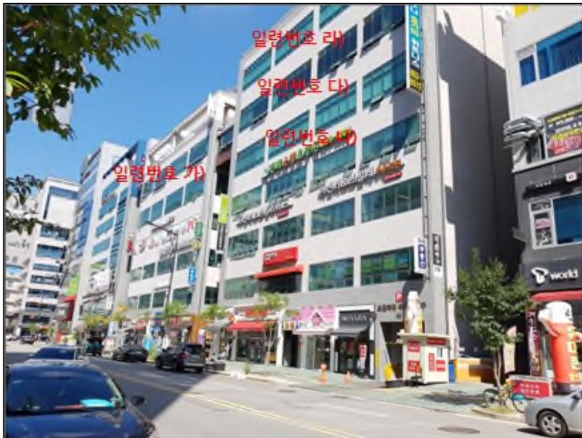
[ 대상물건 전경(남동측에서 촬영) ]
