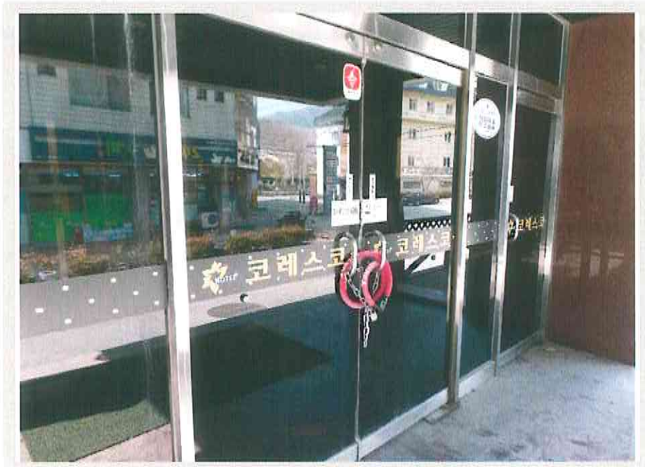
【본건 출입문 잠금장치】
